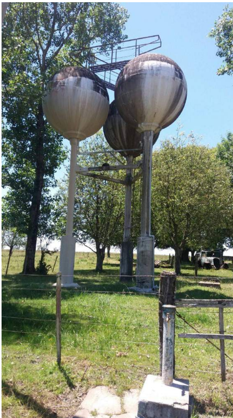
Figura 30. Tanques de depósito de agua ubicados a 200m de las piletas de tratamiento de MEVIR y próximos a la Cañada de la Bomba, en los cuales se realizó la primer descarga de agua para la máquina vaporara (Barla y Machado 2017).
